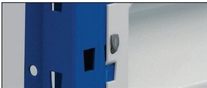
7 Coloque os pinos de segurança no orifício previsto para o efeito. Assim evitará qualquer desmontagem acidental das vigas durante as operações de carga e de descarga das prateleiras. Tenha o cuidado de respeitar o número de níveis suficiente para não ultrapassar a carga máxima por estrutura.
